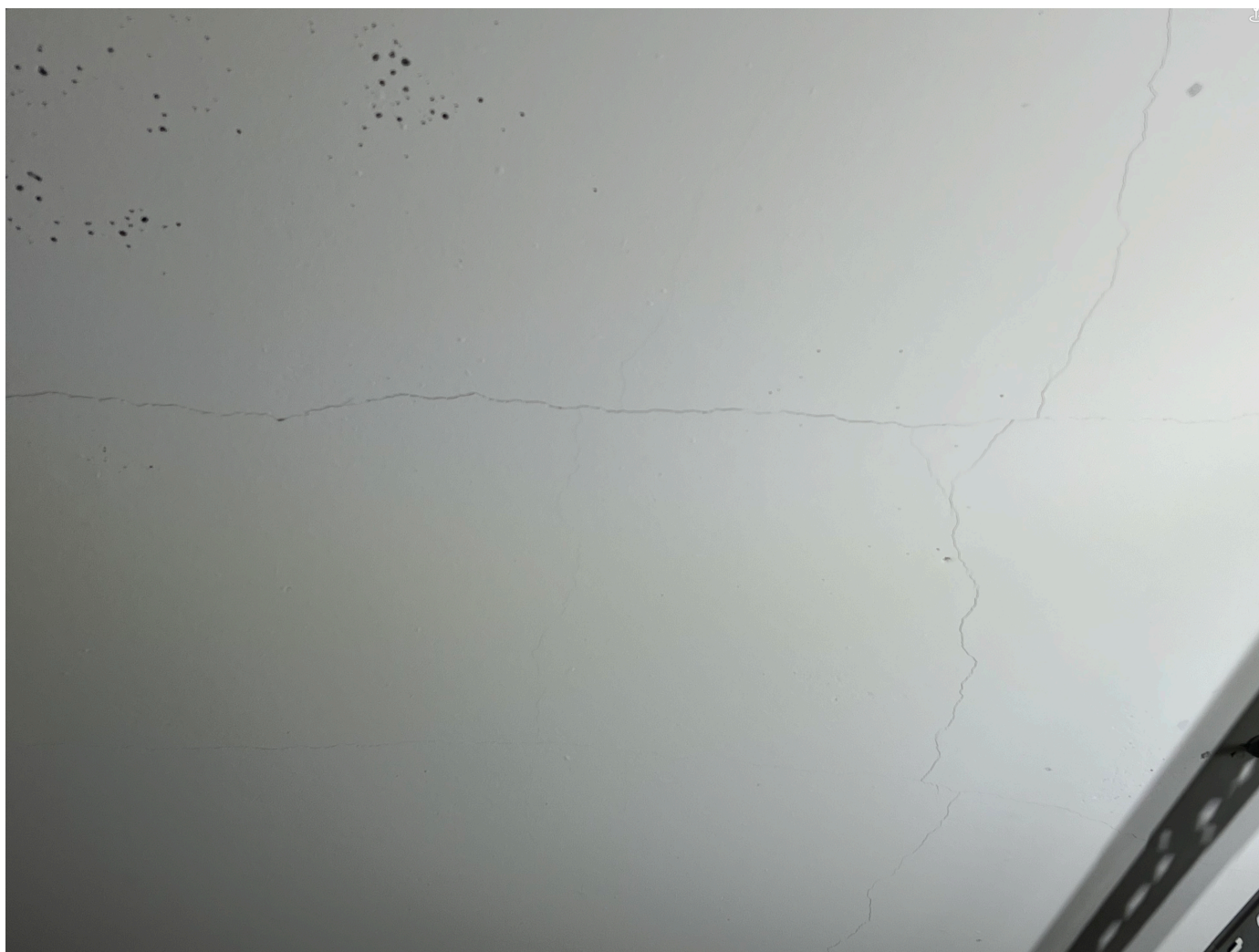
Fot. nr 4. Przykład zarysowań stropu.
