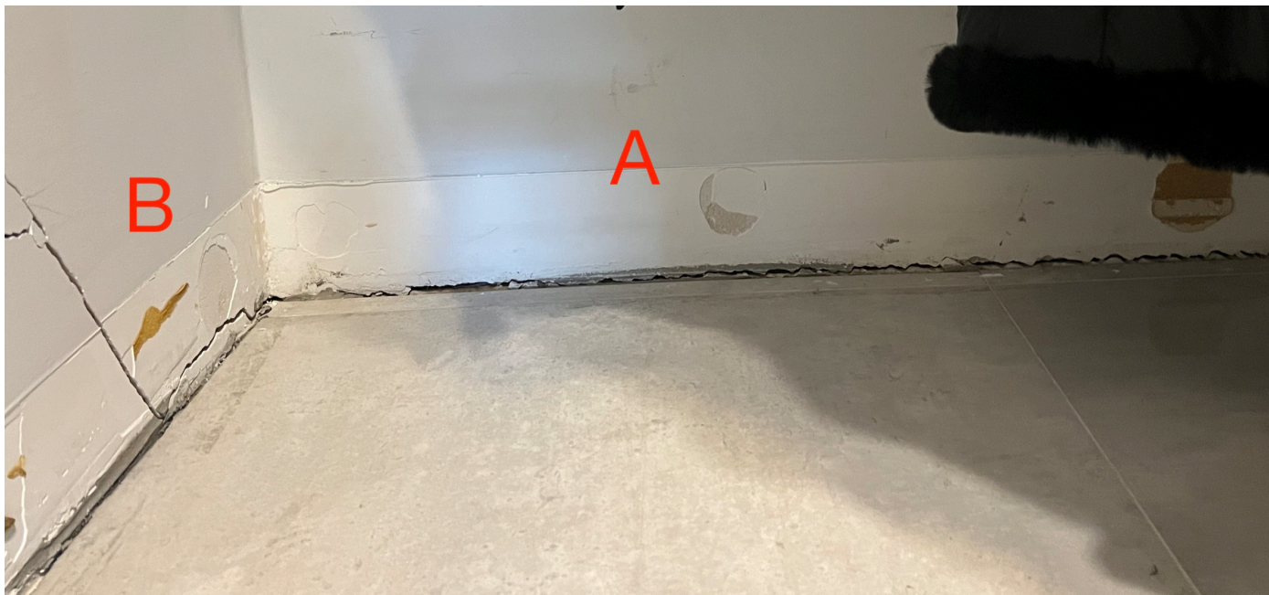
Fot. nr 6. Pęknięcie ściany w poziomie pierwszej spoiny wspornej - widok od lokalu mieszkalnego Widoczne również zarysowania ściany „B”
