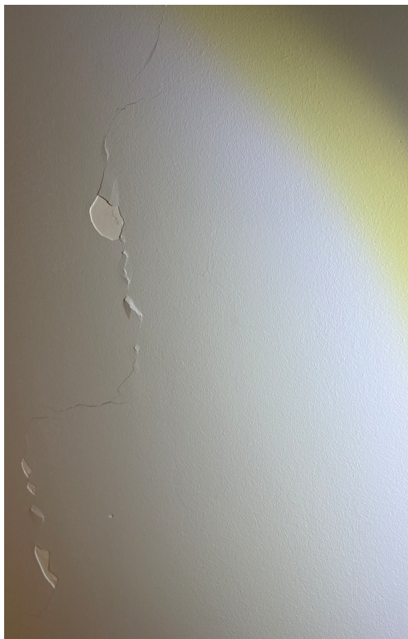
Fot. nr 7. Zarysowanie ściany „A” widoczne od strony lokalu mieszkalnego.
