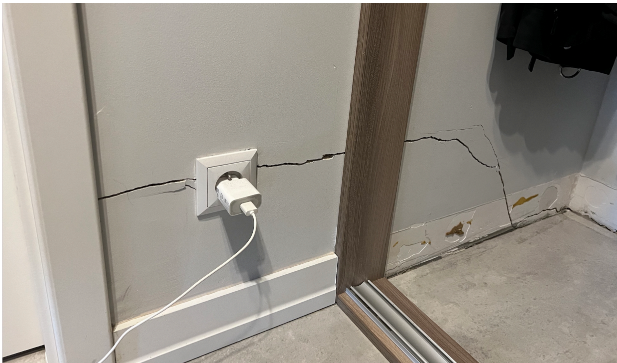
Fot. nr 8. Zarysowania ściany „B”
