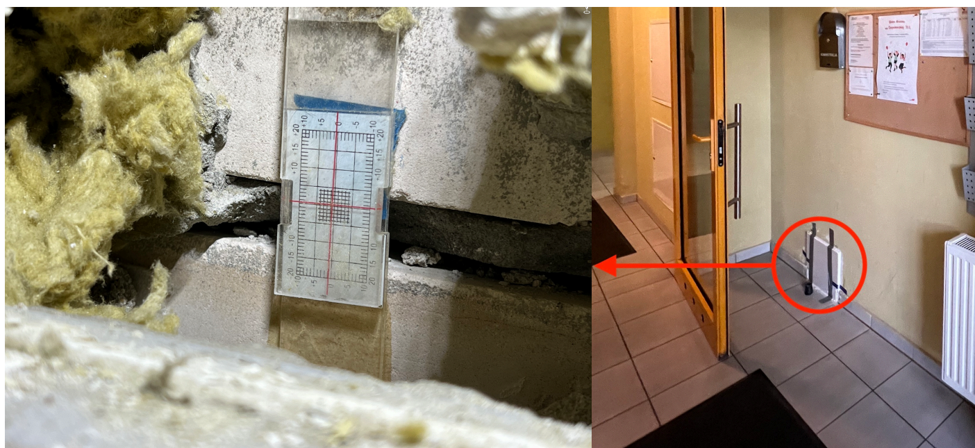
Fot. nr 5. Pęknięcie ściany w poziomie pierwszej spoiny wspornej - widok od strony przedsionka
