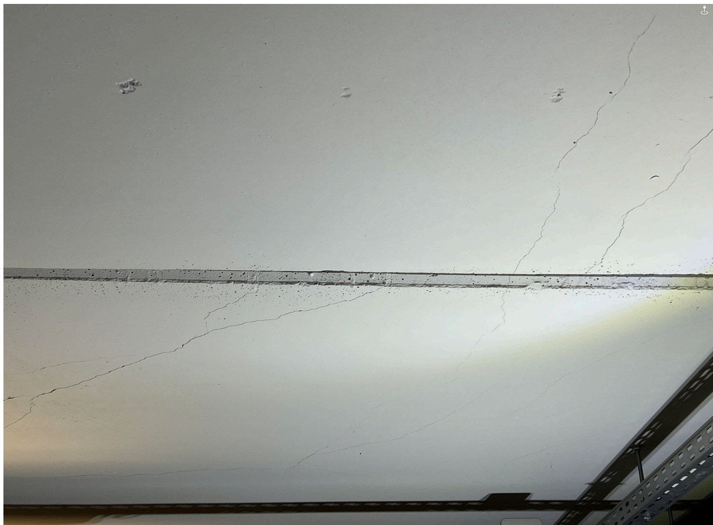
Fot. nr 3. Przykład zarysowań stropu.
