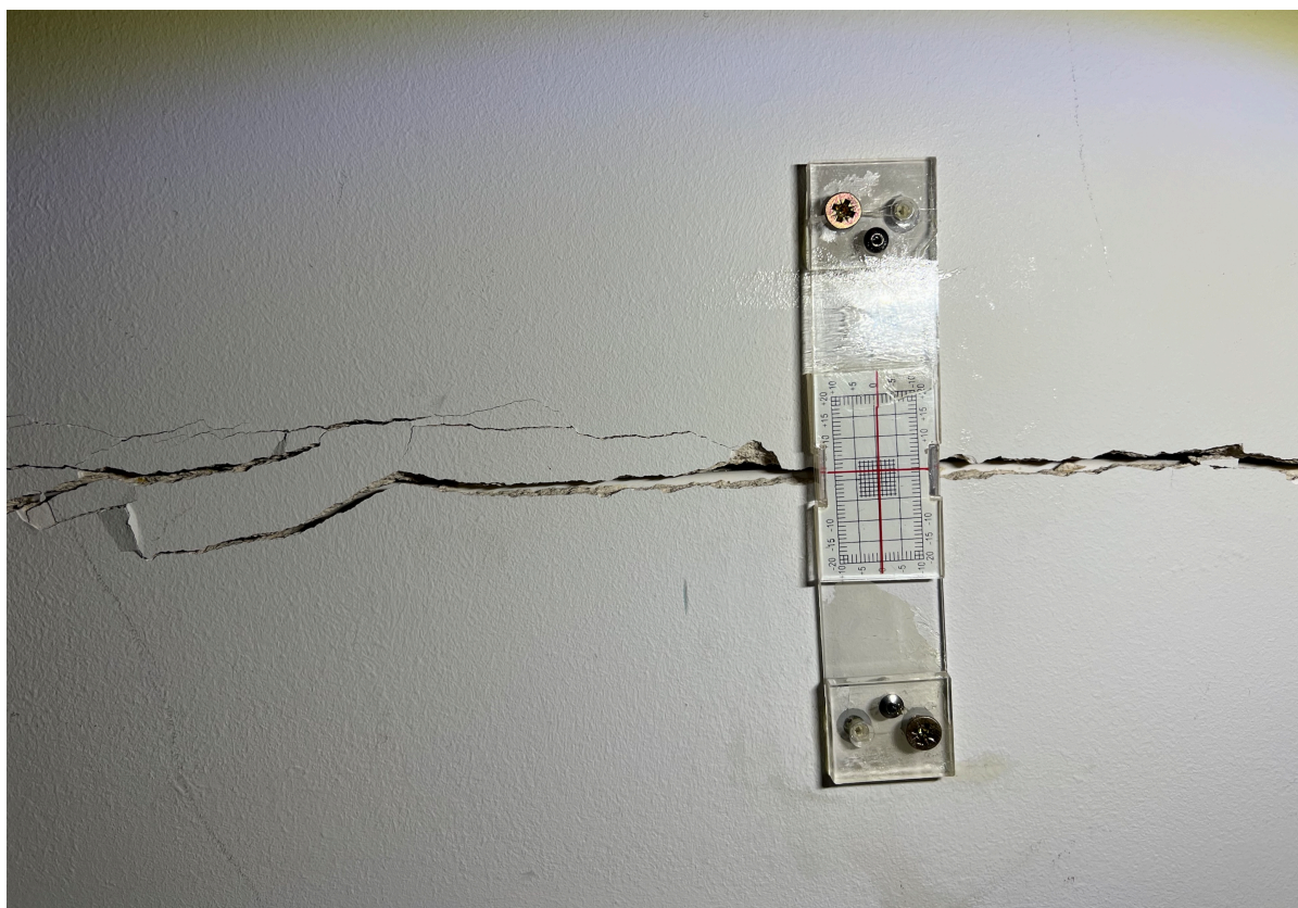
Fot. nr 9. Zarysowania ściany „B”
